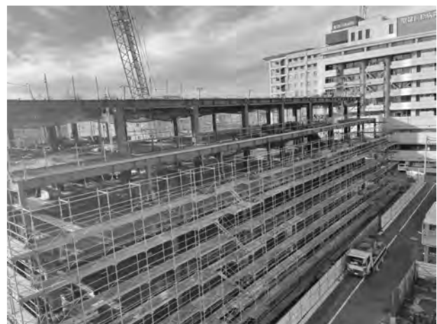
鉄骨工事完了時
