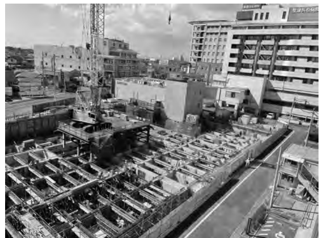
基礎工事完了時
